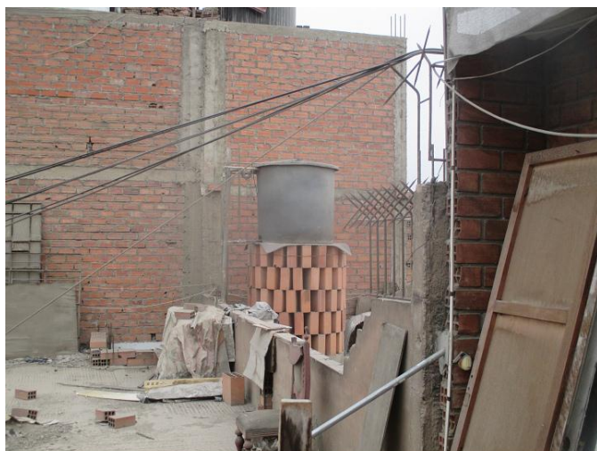
Tanque peligroso en ladrillos no más en el techo de la casa vecina - pasaje Amarilis 184 (casa con cuna con karate en el piso 1 y con discoteca ilegal en el piso 2)
